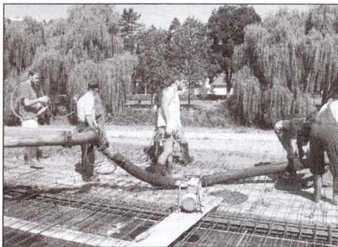
Трећа илоча Дома истраживача
